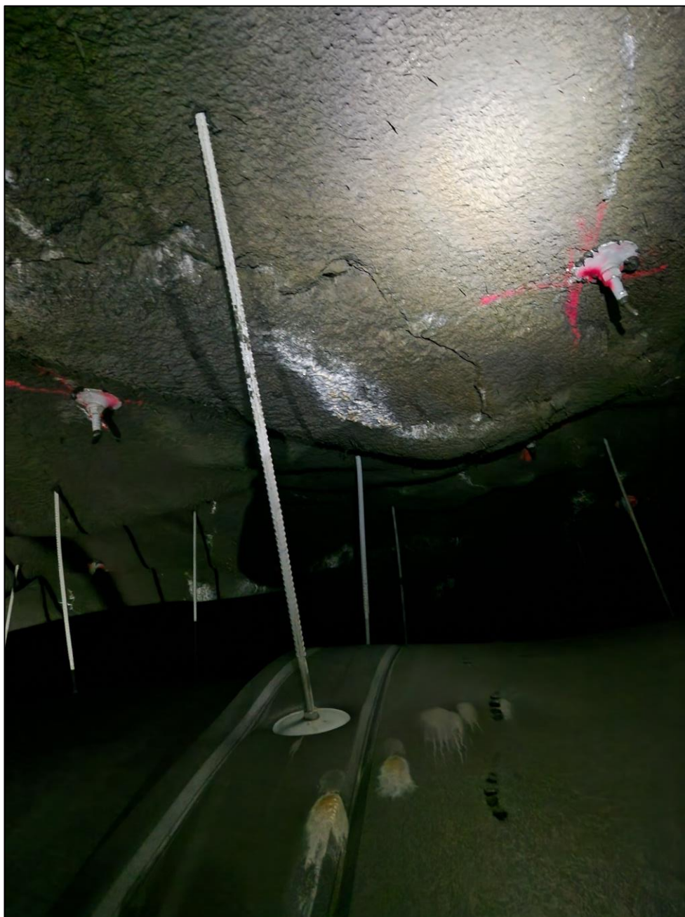
Foto 5. Sprekk observert på spesialinspeksjon i betong pel ca. 20 høyre side bak hvelv. Sprekk på et par cm bredde. Berg ble observert noen steder i sprekken og sprøytebetong har varierende tykkelse. Anbefaler ny spesialinspeksjon om ett år for å vurdere nødvendigheten av en til to bolter som sikringstiltak.
