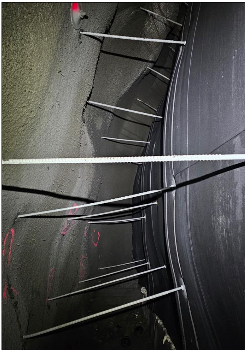
Foto 4. Eksempel på brannskiller bak hvelv.
