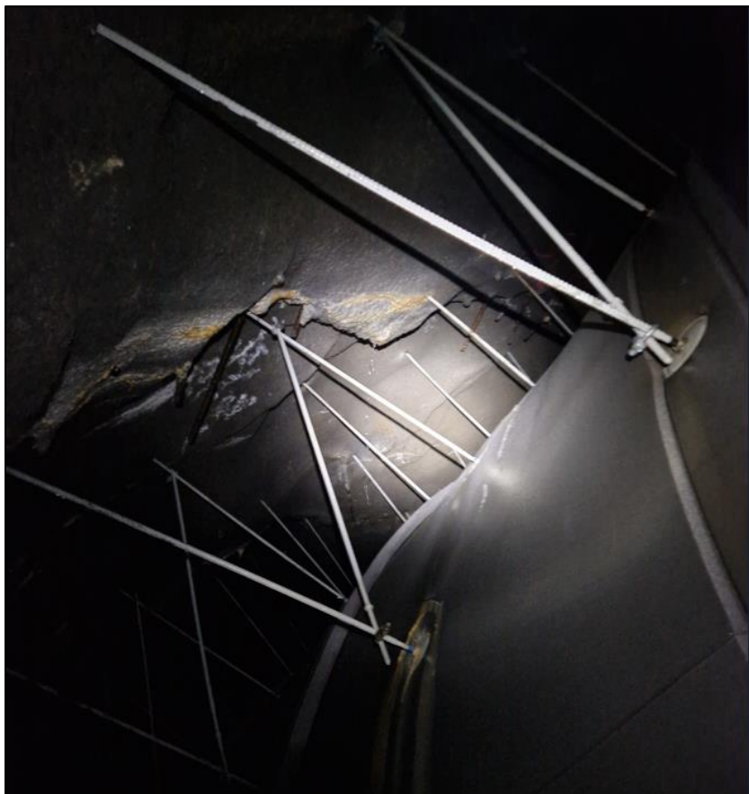
Foto 6. Eksempel på drypp, samt kalk- og rustutfelling bak hvelv.
